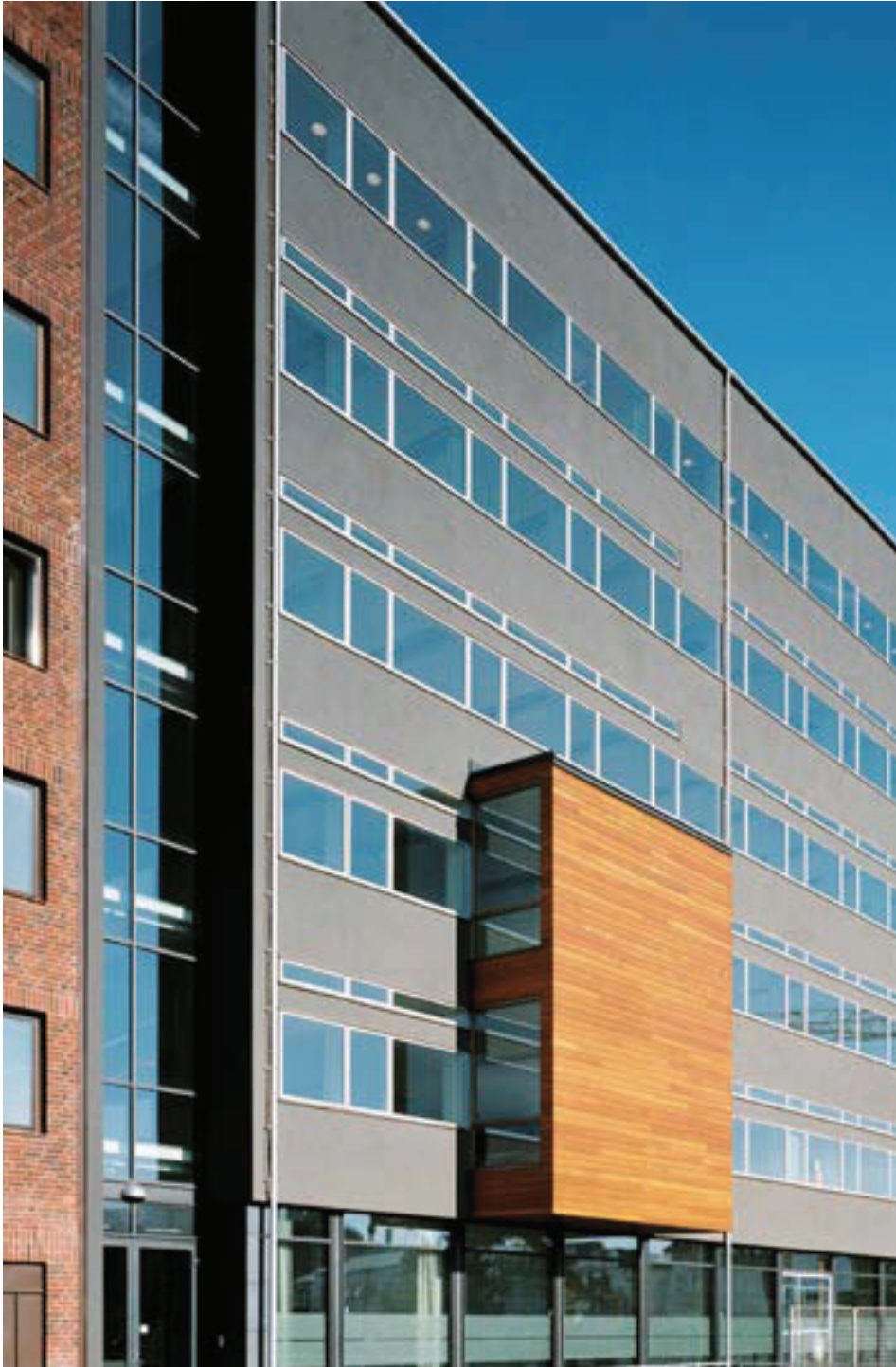
Wohnanlage Scylla 2, S-Malmö Architekturbüro: White arkitekter AB, S-Malmö System: StoVentec R (mit Putz)
