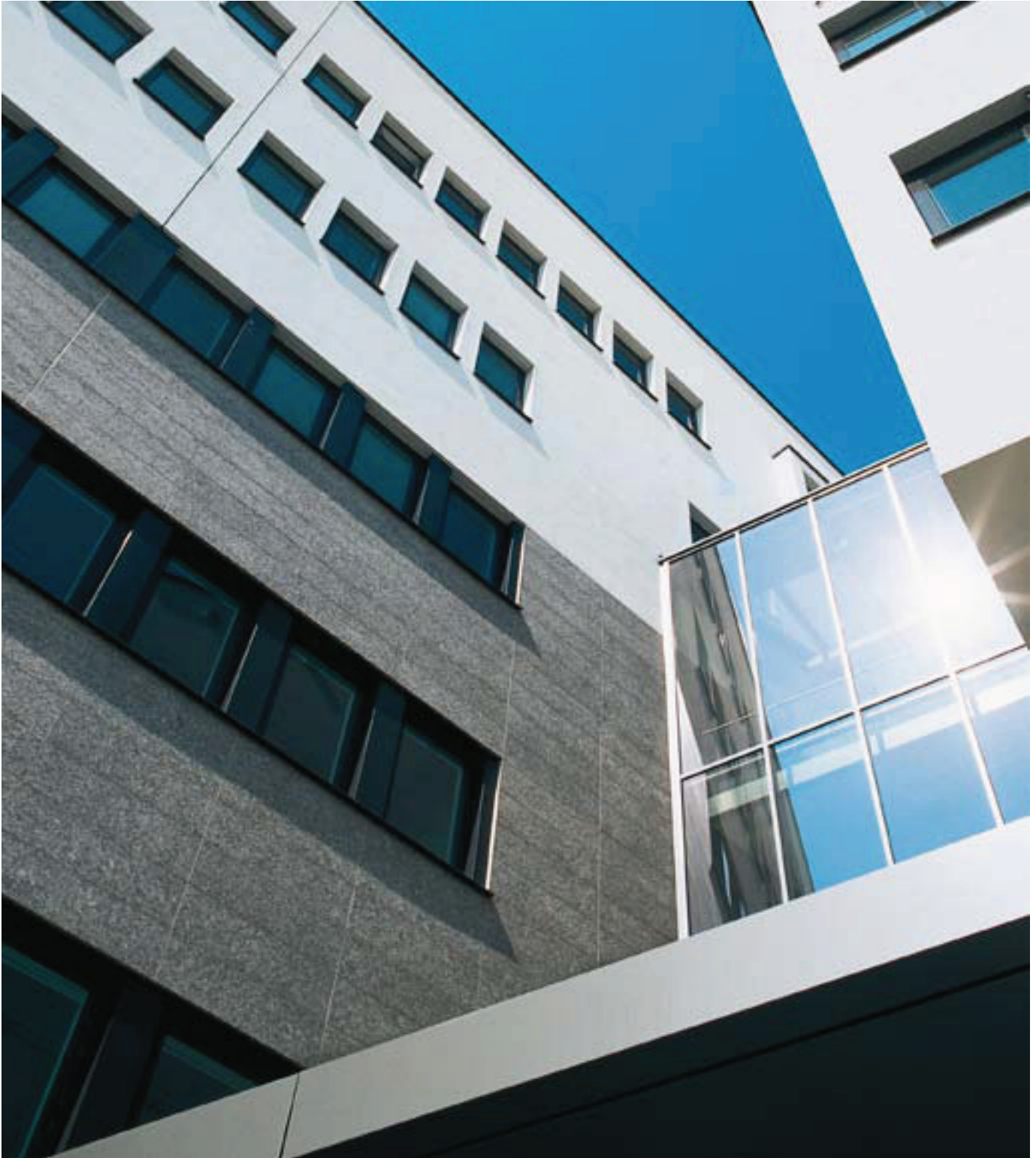
Bürogebäude Drienerbeek, NL-Enschede Architekt: I/AA Architekten & Ingenieures, NL-Enschede Systeme: StoVentec R (mit Putz) und StoVentec S (mit Naturwerkstein)
